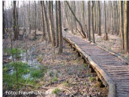
Foto: Fraunhofer IFF
