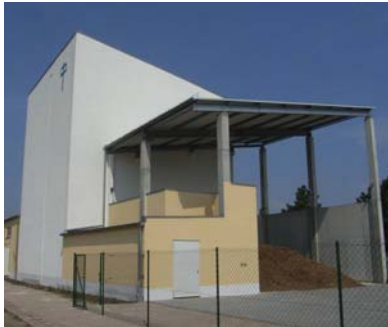
KWK Anlage Wolmirstedt
